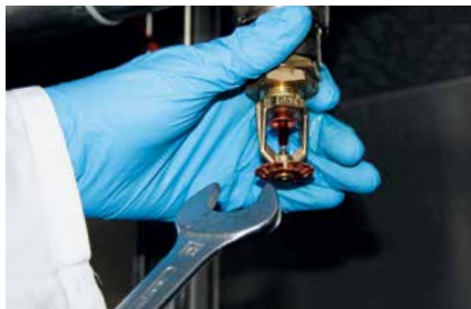
Einbau eines hängenden Glasfasssprinklers
