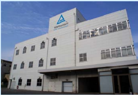
新試験施設外観(大阪市東成区)
